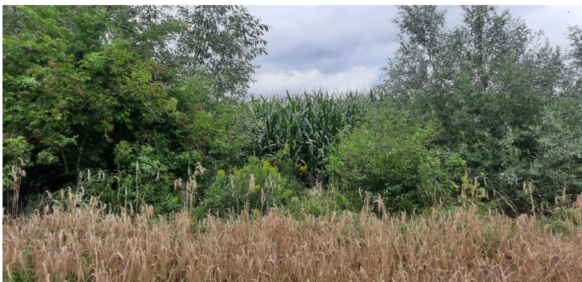
Fot. 6. Rów melioracyjny „D” obręb ewid. nr 0030 Topólno, gm. Gąbin, konserwowany przez członków Spółki Wodnej Gąbin w ramach tzw. „udziału własnego”
