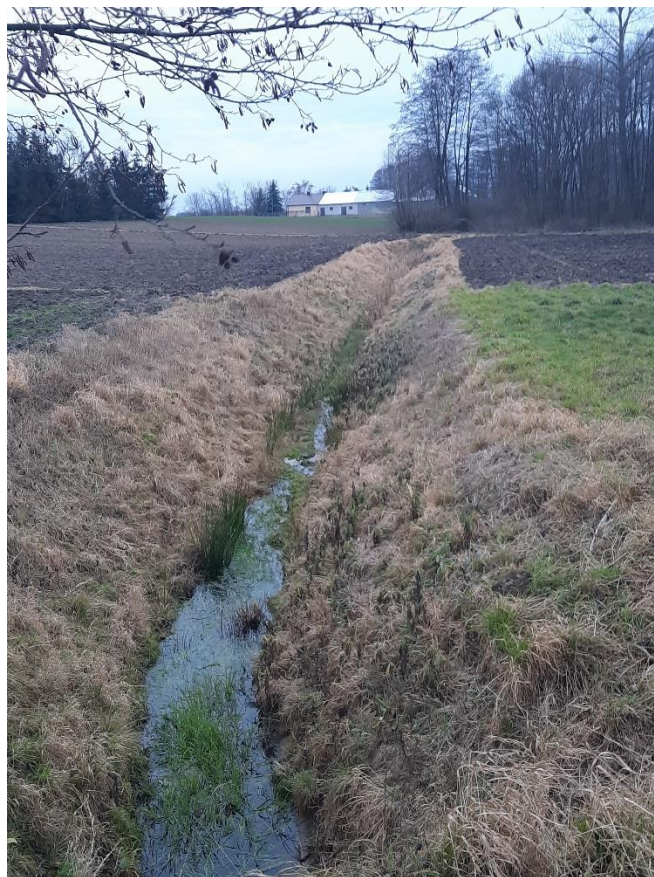
Fot. 3. Rów melioracyjny „A” obręb ewid. nr 0026 Przedbórz, gm. Staroźreby, konserwowany przez członków Spółki Wodnej Staroźreby tzw. „udziałem własnym” i Spółkę Wodną Staroźreby
