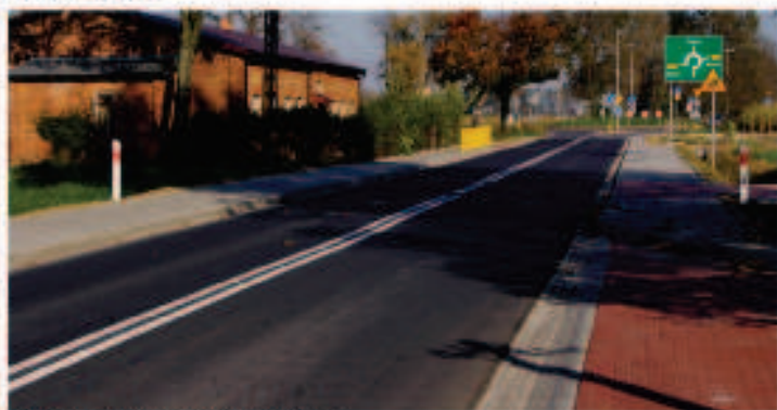
Przebudowana droga powiatowa nr 5201 W
