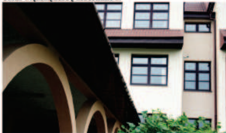
Wykonanie elewacji w Zespole Szkół im. L. Bergerowej w Płocku
