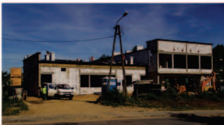
Przedszkole w Nowych Proboszczewicach
