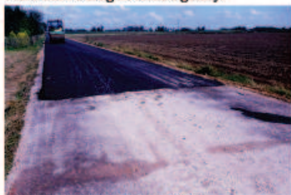
Przebudowa drogi gminnej Blichowo - Gocłowo
