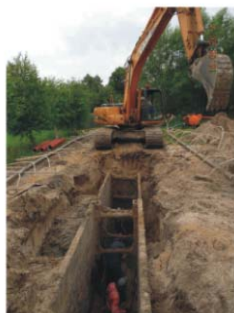
Budowa odcinka w Kotzylawie 4
