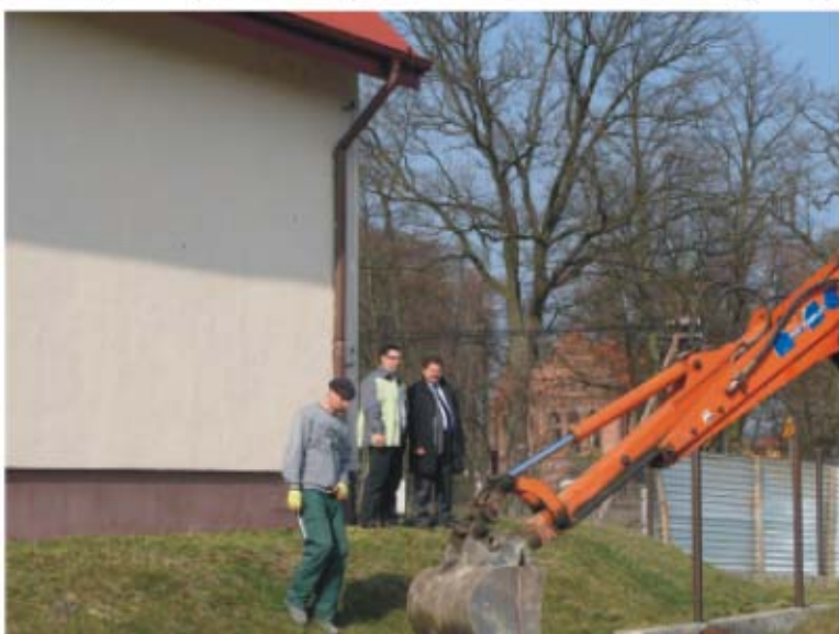
Rozbudowa oczyszczalni w Nowym Duninowie rozpoczęła. W miejscu gdzie dziś stoi będą niebawem stały kolejne zbiorniki.
