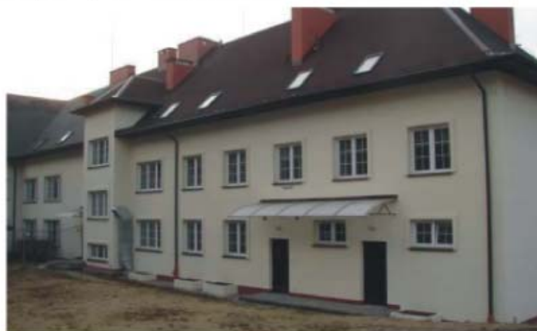
DPS Brwilno – nowe ikrzydło obiektu.
