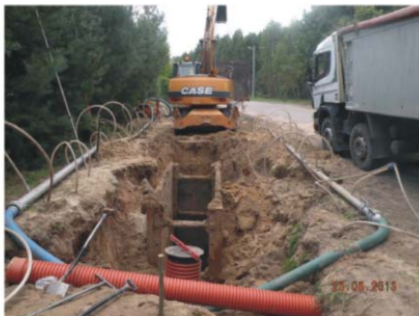
Budowa odcinka w Matyldowie
