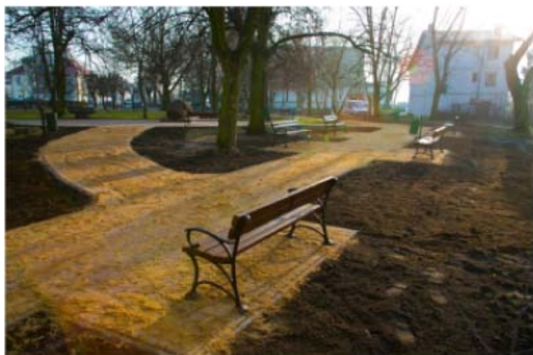
Budowa alejek parkowych w Gąbinie
