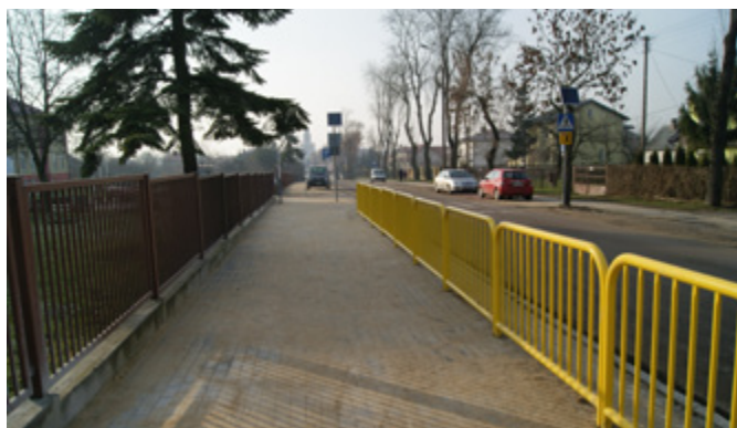
Nowy chodnik w Gąbinie przebiegający wzdłuż drogi powiatowej.
