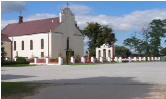
Plac przed kościołem w Rogotwórsku po przebudowie
