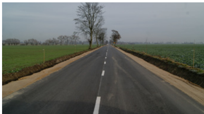
Droga Ilinek – Bodzanów po modernizacji.
