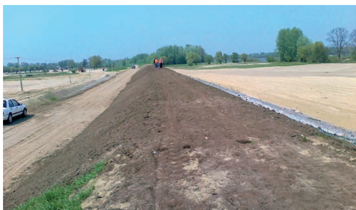
Odbudowane wały przeciwpowodziowe w Świniarach.
