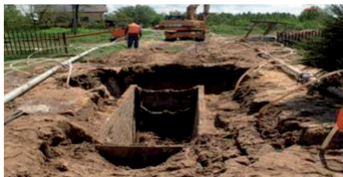
Odwodnienie wykopów w Matyldowie.
