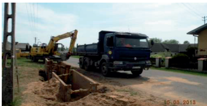
Budowa odcinka kanalizacji sanitarnej w Matyldowie
