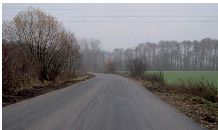
Ułożona warstwa wiążąca nawierzchni drogi powiatowej Słupno-Białkowo.
