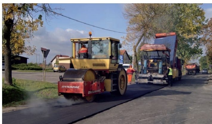
Układanie warstwy wyrównawczej nawierzchni drogi powiatowej na odcinku Rogozino-Bulkowo.
