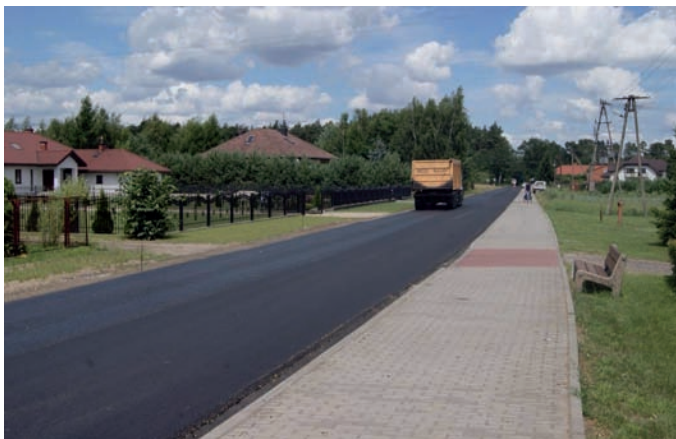
Remont drogi powiatowej Słubice-Piotrkówek.
