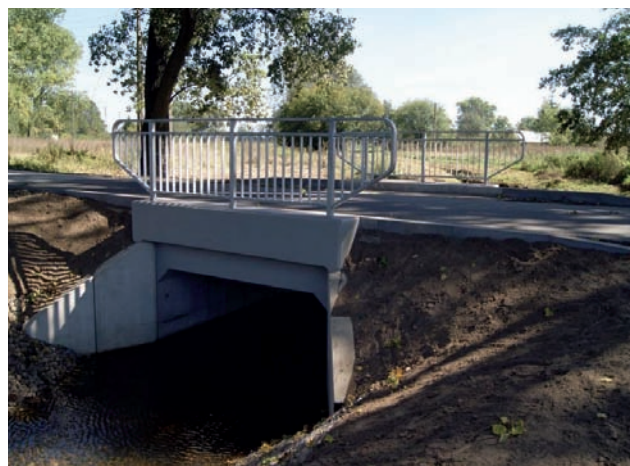
Odbudowany most w Juliszewie gm. Słubice
