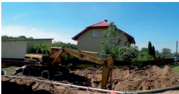
Przewiert przez drogę w Zaździerzcu
