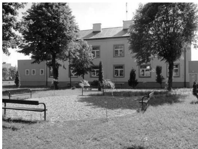
Wyremontowany po powodzi obiekt Szkoły Podstawowej w Świniarach.
