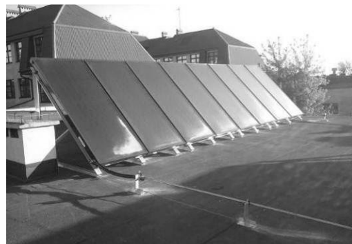
Nowe rozwiązania technologiczne pozwolą na oszczędne gospodarowanie energią cieplną w Zespole Szkół im. L. Bergerowej.
