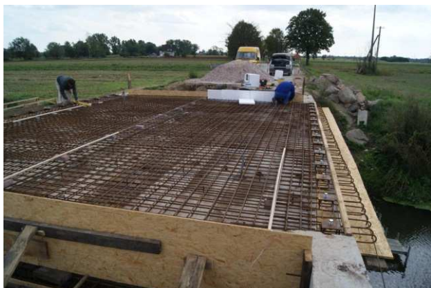
Remont mostu w Troszynie Polskiej w ciągu drogi powiatowej nr 2979W Borki – Troszyn Polski.
