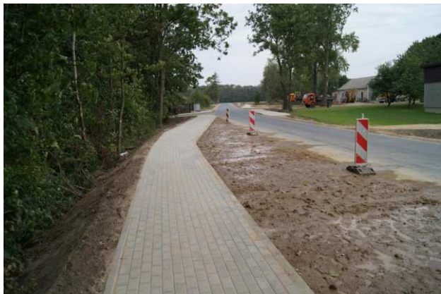
Modernizacja drogi powiatowej nr 2924W Bulkowo-Góra na odcinku 4,8 km realizowana w ramach Narodowego Programu Przebudowy Dróg Lokalnych 2008-2011 przy udziale finansowym gminy Bulkowo.
