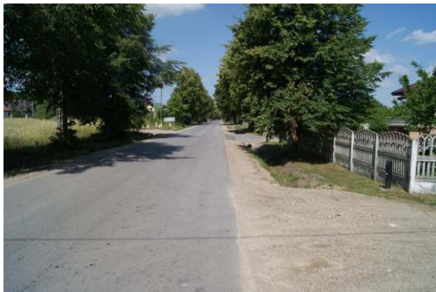
II etap remontu drogi powiatowej nr 5206W Płock - Dobrzyków na odcinku o długości 3161 m.
