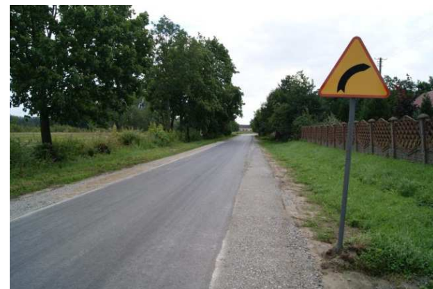
Zmodernizowana droga powiatowa nr 6915W Wymysle Polskie-Nowosiadło-Piotrkówek-Ilów na odcinku długości 1,960 km.
