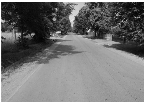
Wykonane odwodnienie na drodze powiatowej nr 5206 Płock – Dobrzyków.
