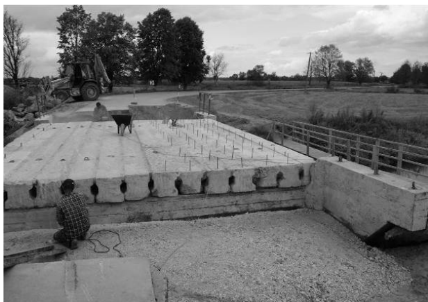
Remontowany most w miejscowości Troszyn Polski.
