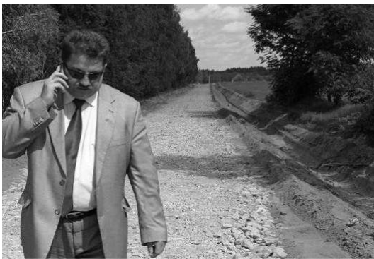
Przebudowa drogi gminnej w Lipiankach. Droga łączy się z drogą powiatową nr 2972W.
