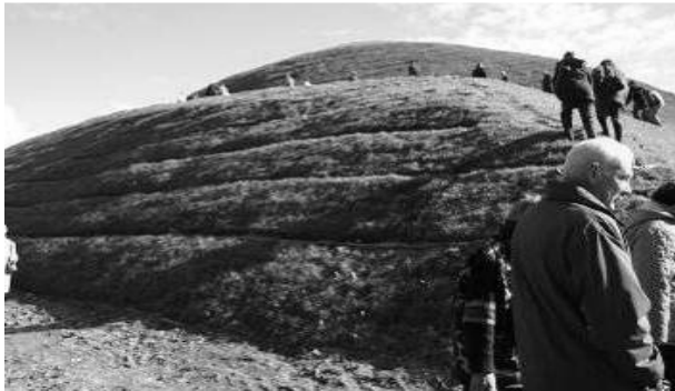
Kwatera A na składowisku w Cieszewie
