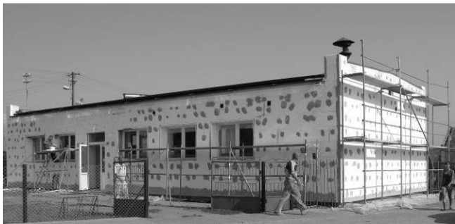
Termomodernizacja strażnicy w Nowym Duninowie. W ramach podpisanego porozumienia z OSP Wójt Gminy zapewnia pomoc merytoryczną przy opracowaniu dokumentów niezbędnych do złożenia zasadniczego wniosku, pomoc przy prowadzeniu postępowania przetargowego i rozliczeniu inwestycji oraz pomoc finansową.
