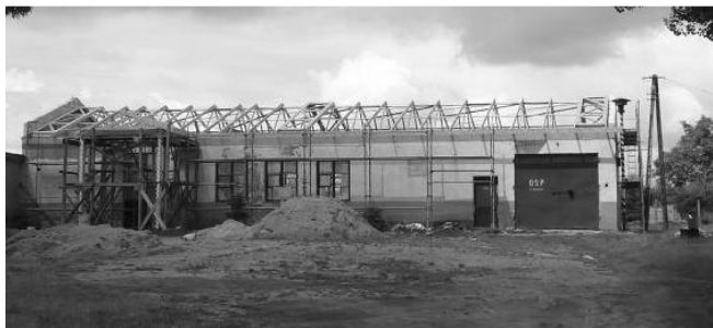
Remontowana remiza OSP w Ciachcinie.
