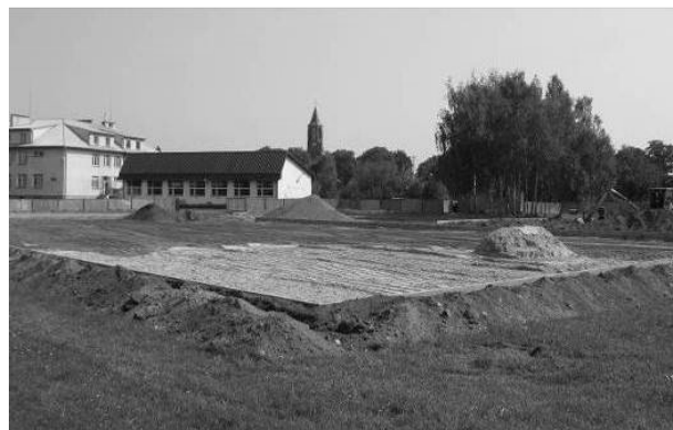
Budowa boisk przy szkołach w Nowym Duninowie w ramach programu "Moje Boisko Orlik 2012". Sierpień 2011 r.
