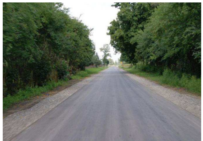
Wyremontowana droga powiatowa nr 6915W Wymysle Polskie-Nowosiadło ze środków rządowych na usuwanie klęsk żywiołowych.
