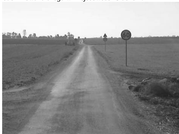
Zmodernizowana droga w miejscowości Leszczyn Księży.
