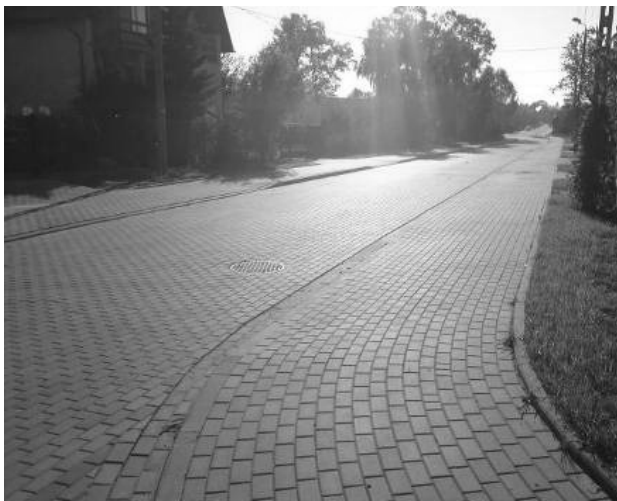
Przebudowa i modernizacja ulic w miejscowości Bielsk.
