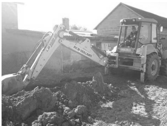
Budowa przydomowych oczyszczalni ścieków.
