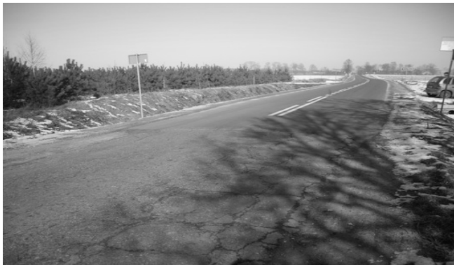
W ubiegłym roku została zakończona modernizacja drogi na odcinku Góra do granicy Gminy Bulkowo.
