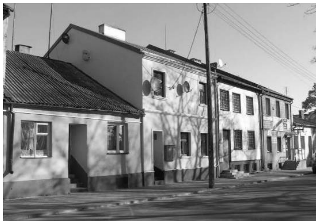
Remont elewacji budynków przy ul Rynek w Drobinie.
