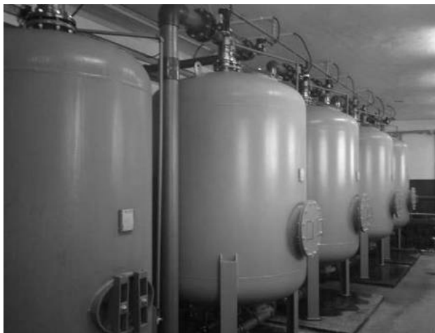
Wyremontowana stacja uzdatniania wody w Józinku.
