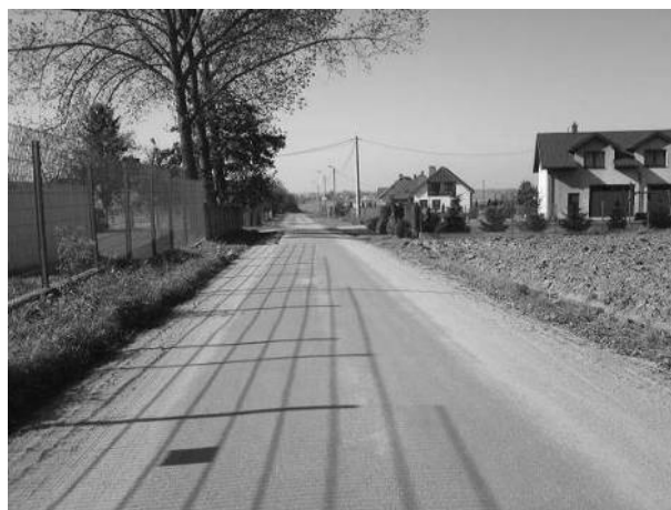
Zmodernizowana droga w miejscowości Ciachcin.
