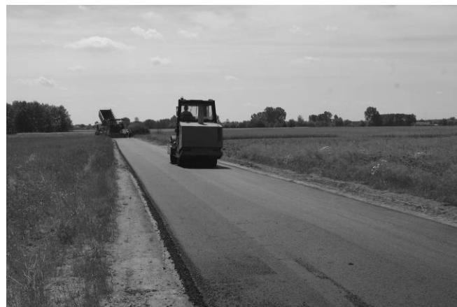
Remont drogi powiatowej nr 6915W Wymyśle Polskie – Nowosiadło – Piotrkówek - Iłów na odcinku od km 8+900 do km 10+860 długości 1,960 km wraz z remontem przepustu w km 5+500.
