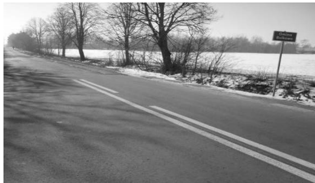
Granica Gmin Bulkowo – Staroźreby. Tak będzie wyglądała droga po przebudowie.
