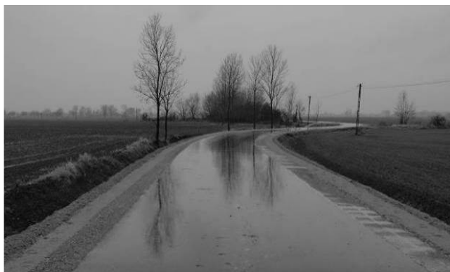
Droga Nowosiadło-Troszyn po przebudowie.
