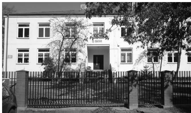
Budowa ogrodzenia oraz zagospodarowanie terenu przy Szkole w Ciachcinie 1.
