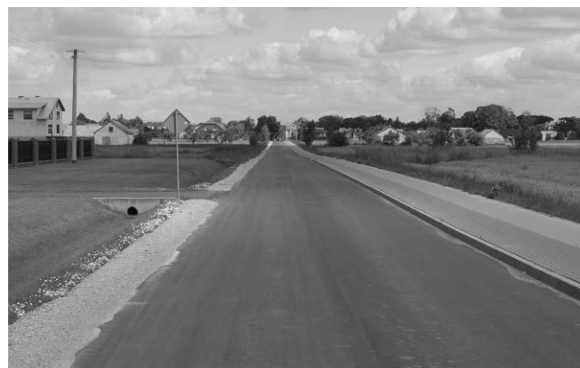
Odnowiona nawierzchnia drogi powiatowej nr 2911W w miejscowości Drobin.
