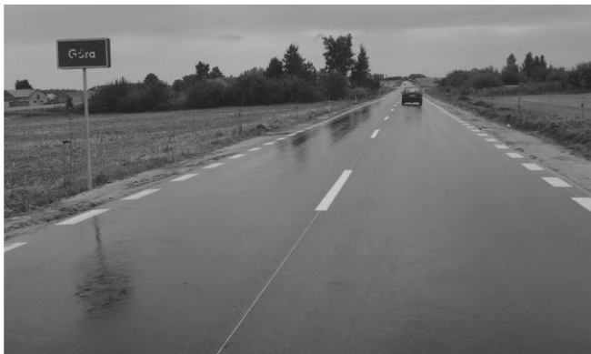
Przebudowa (modernizacja) drogi powiatowej nr 2924W.
