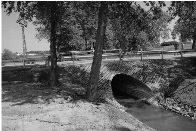
Przebudowany most w Białkowie.
