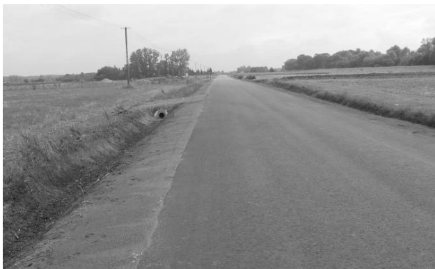
Przebudowana droga powiatowa Nr 2963W Kępa Polska-Podgórze-Rakowo-Wyszogród w m. Rakowo.
