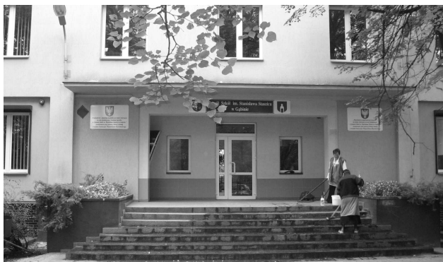
Zmodernizowany budynek Zespołu Szkół im. St. Staszica w Gąbinie.
