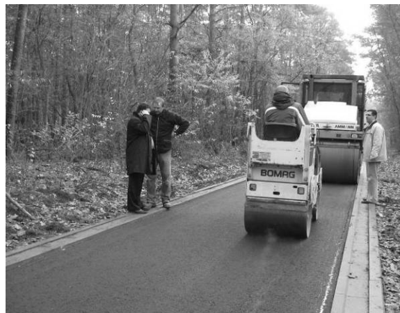
Droga gminna Mościska – Dzierżazna w trakcie budowy.
