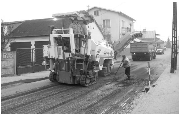
Kończący się remont drogi nr 2927W Staroźreby-Łubki.
