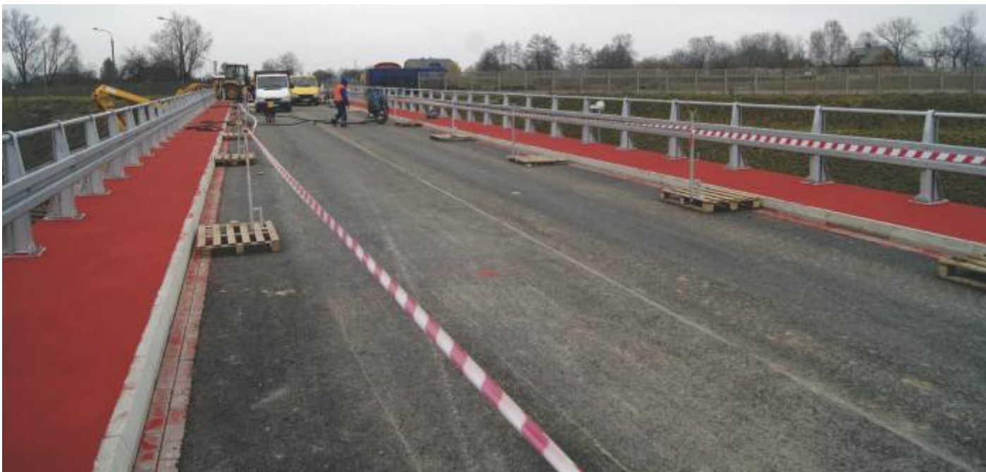
„Przebudowa wiaduktu drogowego w ciągu drogi powiatowej nr 5205W Płock – (gr. miasta) – Draganie – Proboszczewice w m. Nowe Trzepowo, gmina Stara Biała”.
