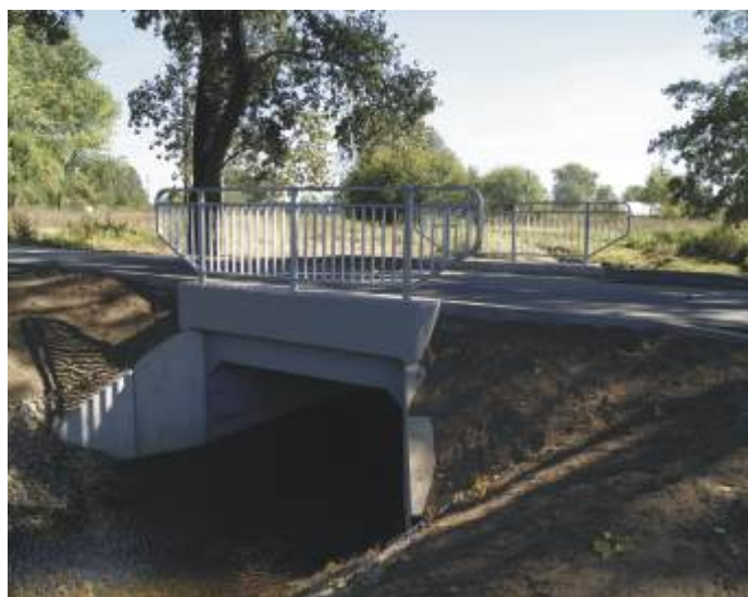
Rozbiórka i odbudowa mostu w miejscowości Juliszew.
