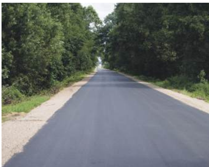
Remont drogi powiatowej Słubice-Piotrkówek.
