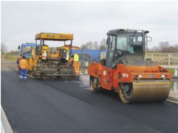
„Przebudowa wiaduktu drogowego w ciągu drogi powiatowej nr 5205W Płock – (gr. miasta) – Draganie – Proboszczewice w m. Nowe Trzepowo, gmina Stara Biała”.
