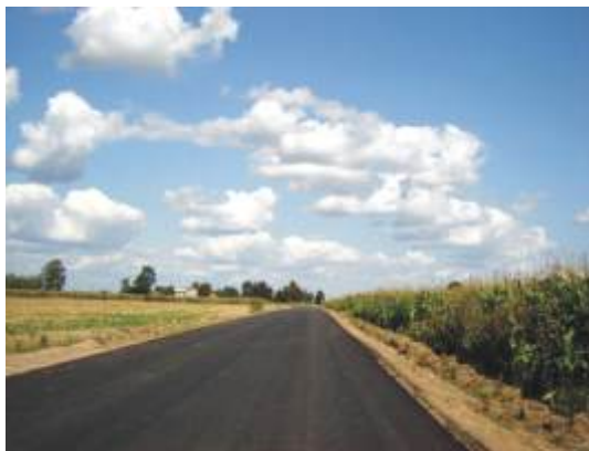
Droga gminna relacji Drobin – Dobrosielice - Kowalewo
